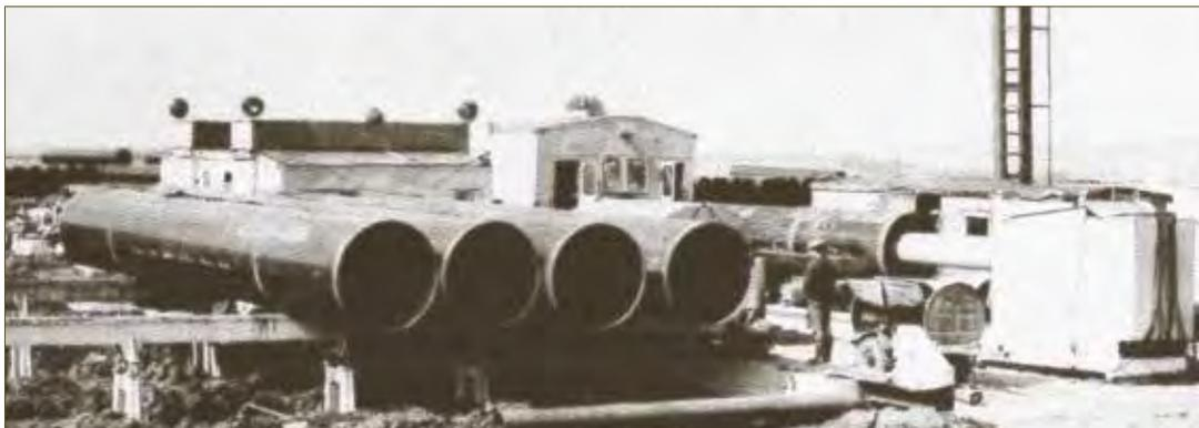
К середине 1960-х годов разработаны и успешно внедрены полустационарные контактно-сварочные установки ТКУС-1, получившие признание в СССР и за рубежом.
