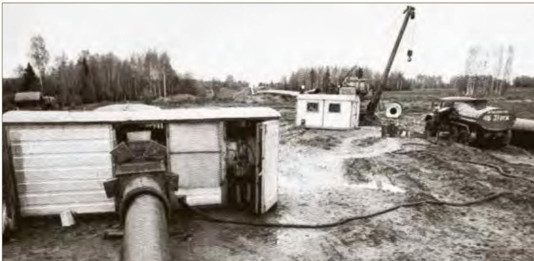
**Мобильная компрессорная установка для продувки и вытеснения воды из трубопровода.**
