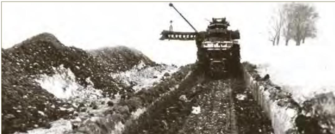
**Снятие плодородного слоя в зимний период на трассе Салават – Уфа роторным экскаватором с дополнительным оборудованием для рекультивации**
