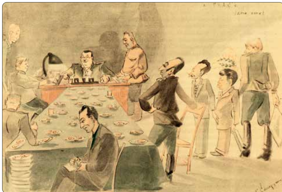
1945 год. В штабе строительства газопровода Саратов — Москва.
