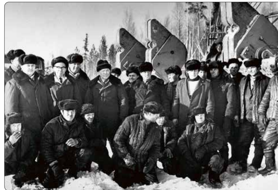
Е. К. Лигачёв, Г. Н. Судобин, А. К. Кортуннов с коллективом изоляционно-укладочной колонны на строительстве магистрального нефтепровода Лександровское — Анжеро-Судженск
