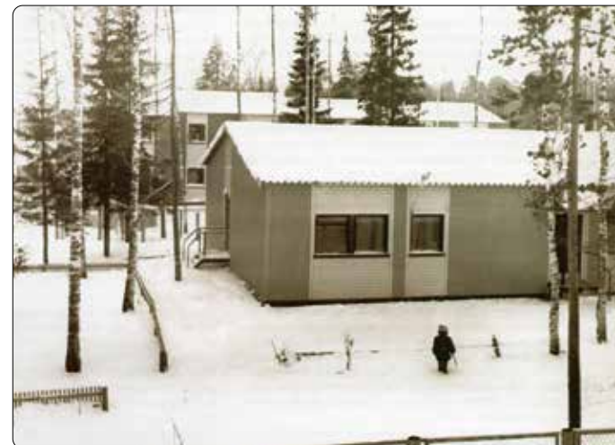
Детский сад на 50 мест в жилом комплексе треста «Комсомольсктрубопроводстрой»
