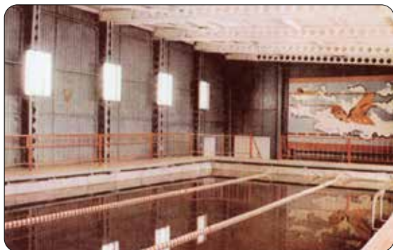
Спорткомплекс с бассейном из сборных конструкций в полевом городке
