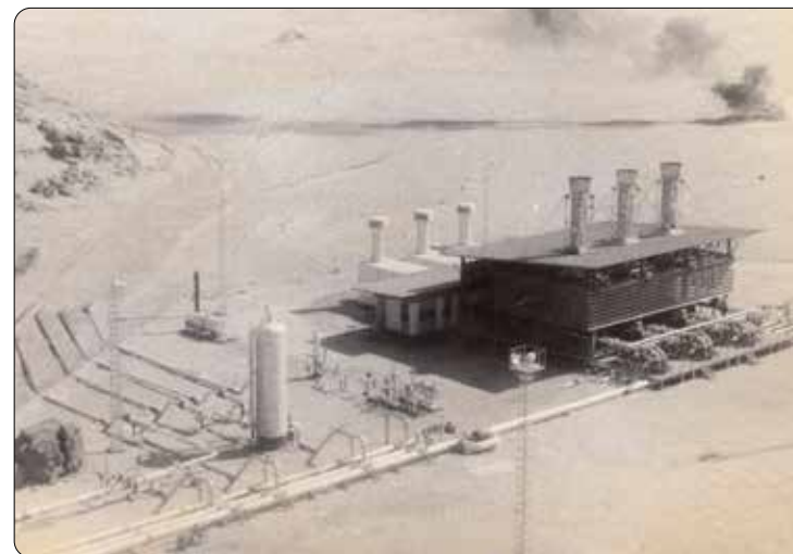
Компрессорная станция на месторождении Хасси-Мессауд
