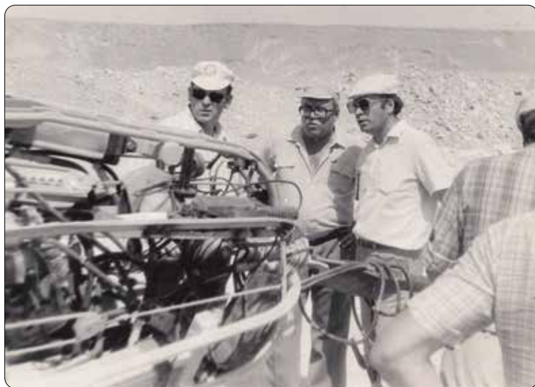
На строительстве нефтепровода Альрар — Тинфуйе
