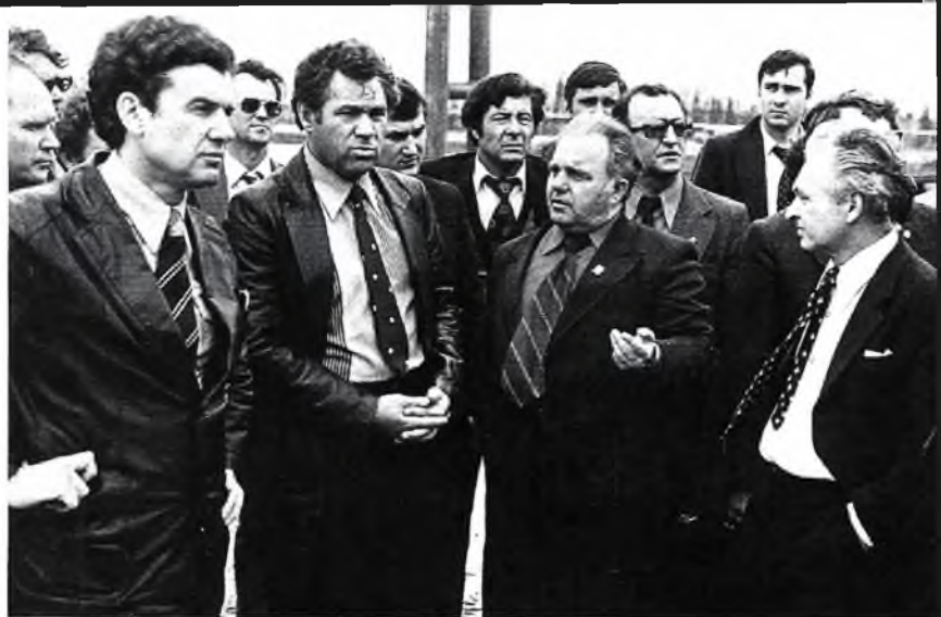
Строительная площадка в Тюменской области. 1979 г.
