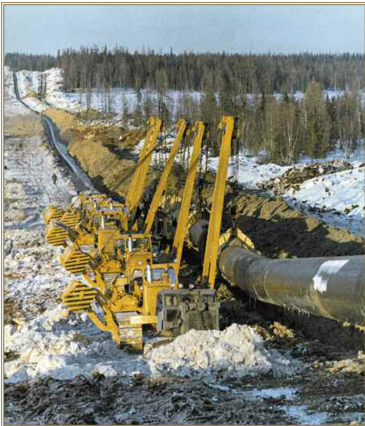
Изоляционно-укладочная колонна на строительстве газопровода, Тюменская обл., 1984 г.
