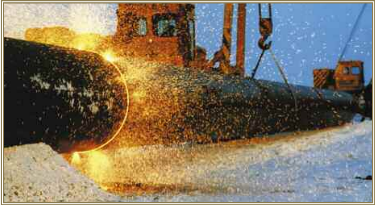
Сварка газопровода, Тюменская область
