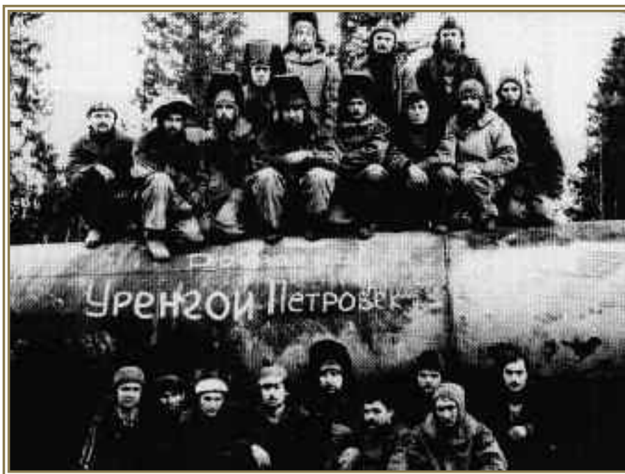
Строители газопровода Уренгой-Петровск, Тюменская область, 1982 г.
