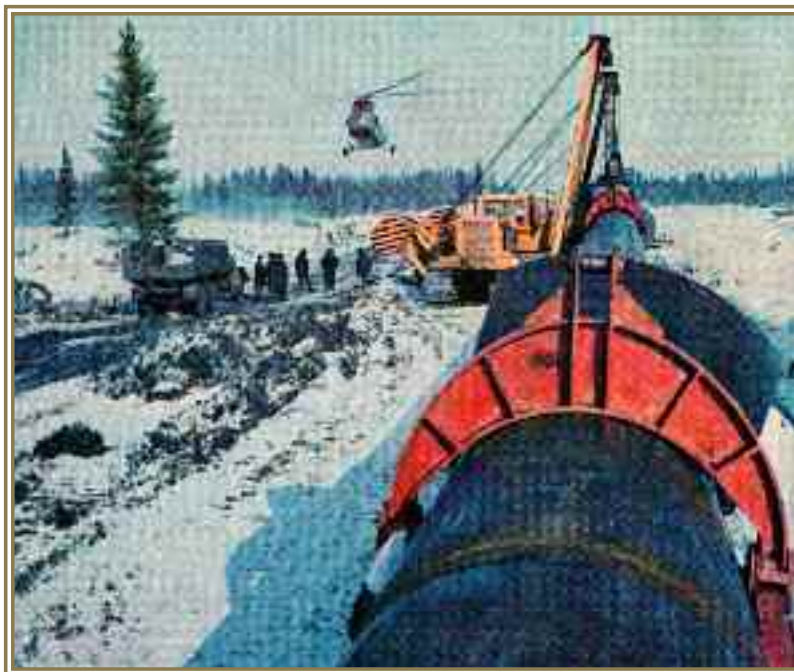
Строится нефтепровод Усть-Балык — Омск, Тюменская обл., 1966г.
