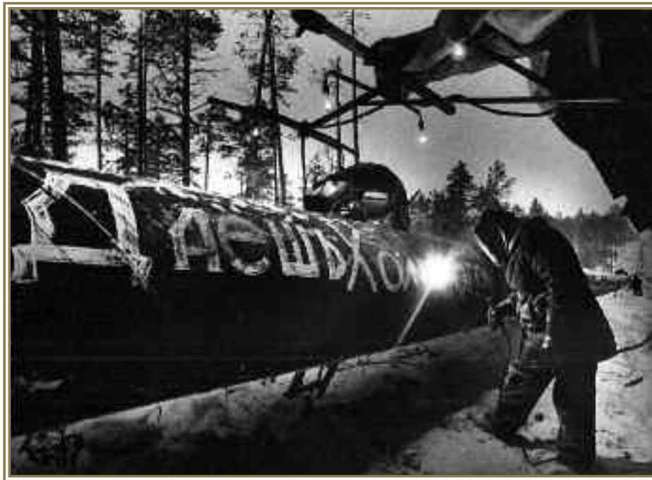
На строительстве нефтепровода Холмогоры – Клин, Тюменская обл., 1984 г.
