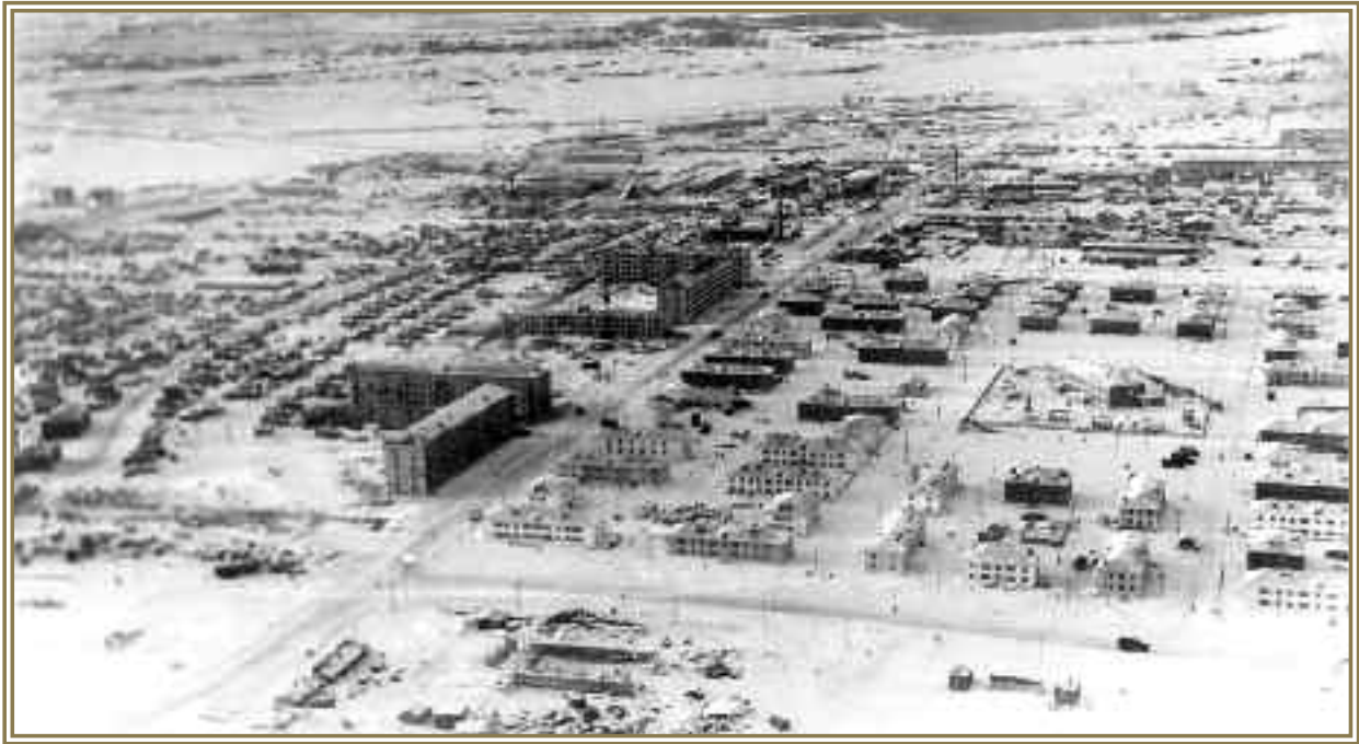
Вид с вертолёта на I и 4 мкр. города Нефтеюганска, Тюменская обл., 1970 г.
