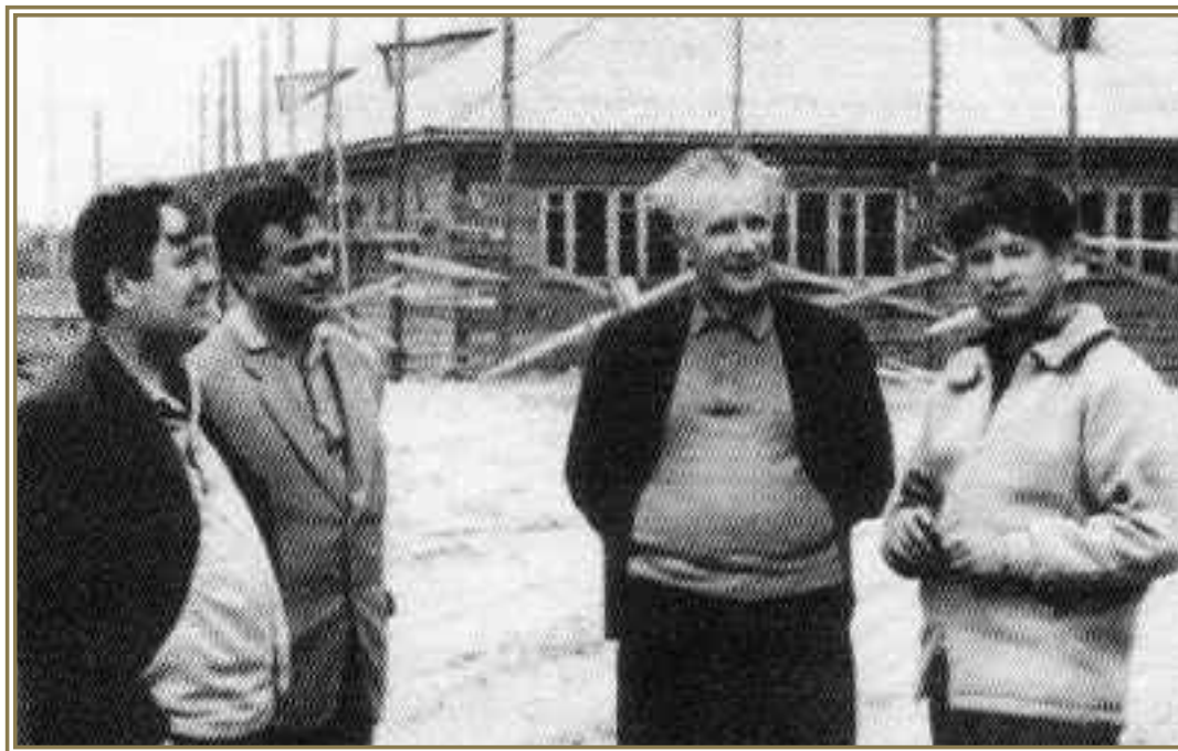
В центре И.И. Тригубенко на строительстве жилого квартала, г. Нефтеюганск, 1970 г.
