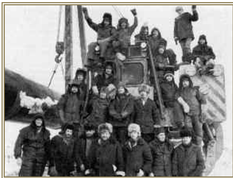
Сварочно-монтажная бригада Бориса Терещенко, трест Севертрубопроводстрой, Ямбург–Елец 1, Тюменская обл. 1985 г.
