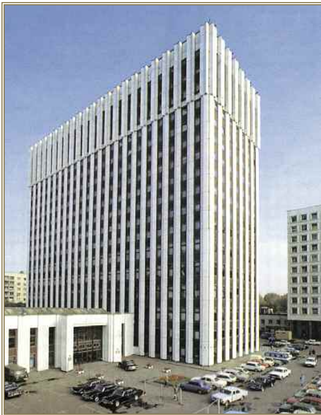
Здание Миннефтегазстроя СССР, г. Москва, ул. Житная, 14
