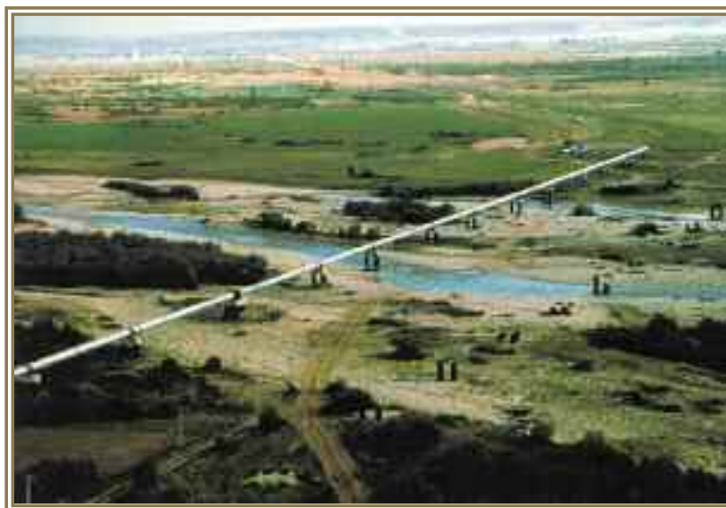
Переход – 985 м через реку Быстрица, газопровод Уренгой – Помары – Ужгород, Карпаты, 1982 г.
