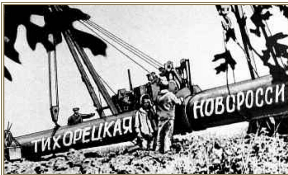
Нефтепровод Тихорецкая – Новоросийск, 1976 г.
