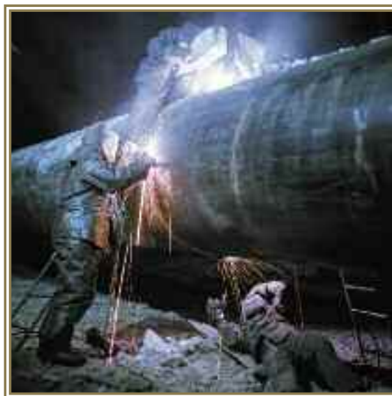
Ночная сварка трубопровода
