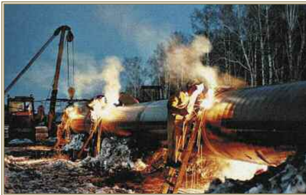
Ночная ручная сварка трубопровода
