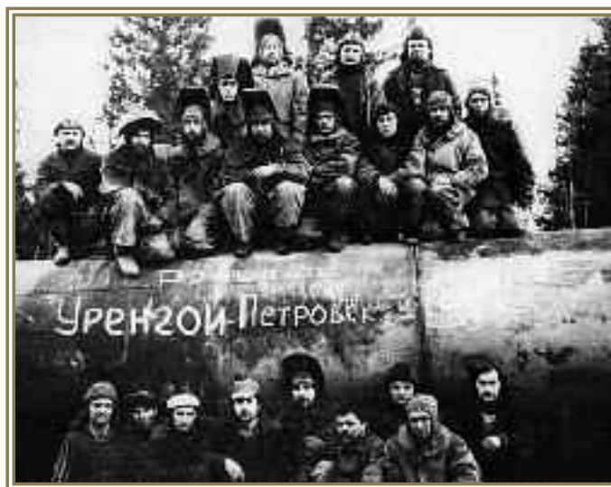
Строители треста Нефтепроводмонтаж газопровода Уренгой – Петровск, 1982 г.
