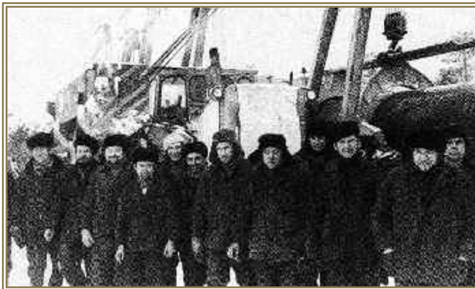
Изоляционно-укладочная колонна П. Сухова СМУ-2 треста Нефтепроводмонтаж., 1976 г.
