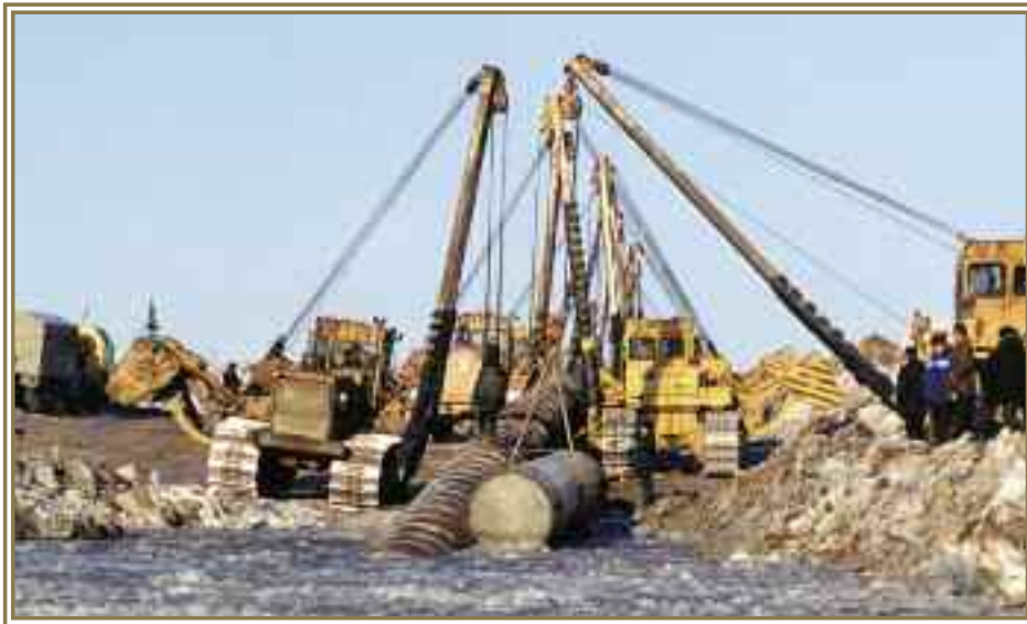
Подводный переход трубопровода
