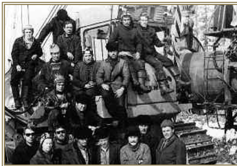
Сварочно-монтажная бригада Н.Р. Сергиенкова, СУ-20, треста «Приобьтрубопроводстрой», 1976 г.
