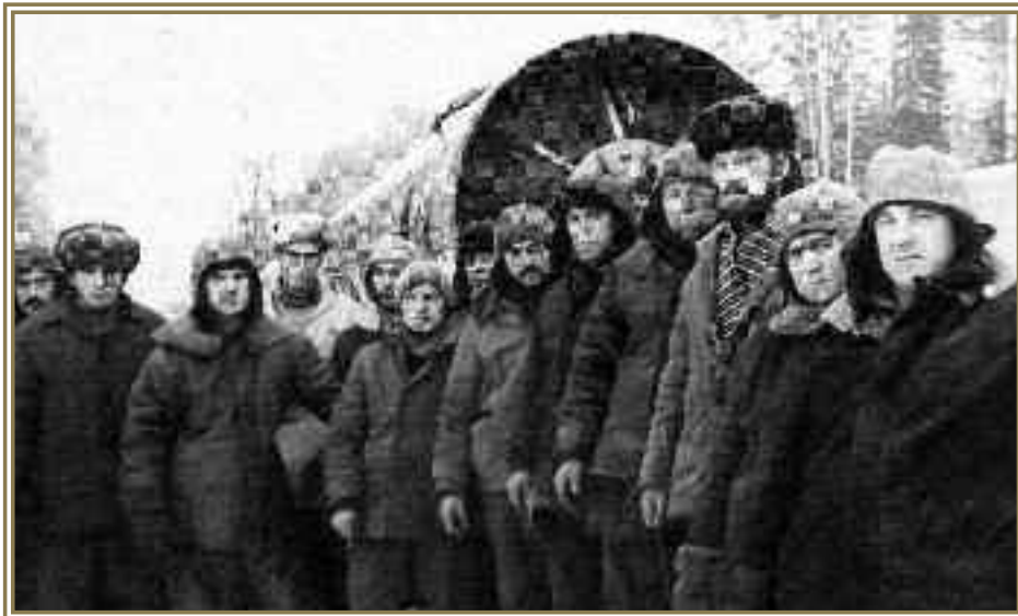
Сварочно-монтажная бригада В. Изаакова СМУ-5 треста Нефтепроводмонтаж
