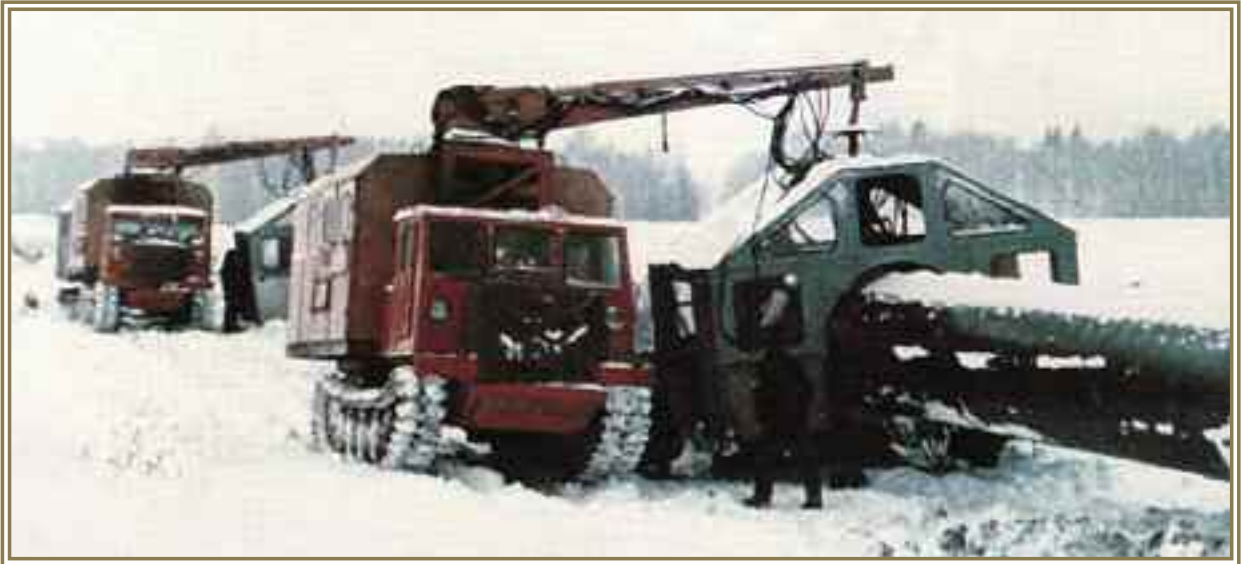
Сварочный комплекс «Стык» в работе
