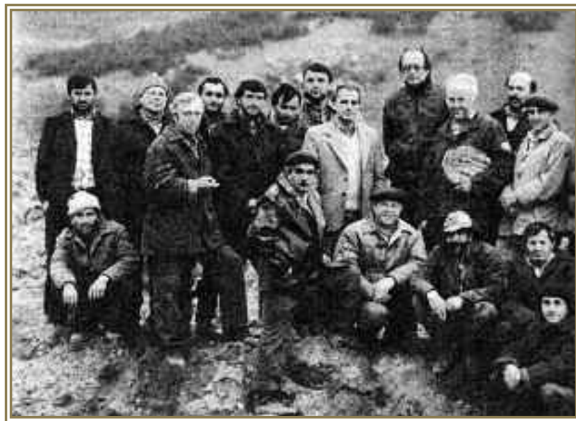
Бригада монтажников Ваника Дагабяна, Спитак, Армения, 1988 г.
