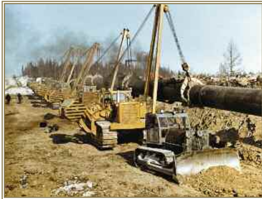
Изоляционно-укладочная колонна в работе
