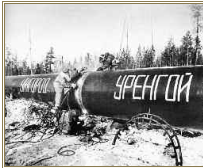
Газопровод Уренгой — Ужгород, Тюменская обл., 1983 г.
