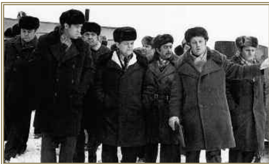
На строительстве компрессорной станции «Приполярная» газопровода Надым — Пунга — Вуктыл — Ухта — Торжок, Тюменская обл., 1977 г.
