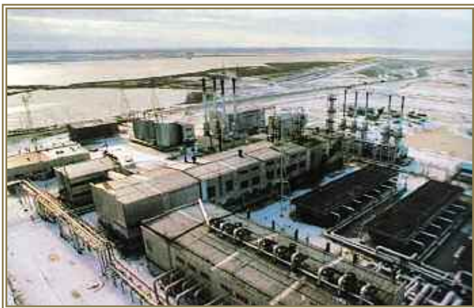
Ямбург, установка комплексной подготовки газа №6
