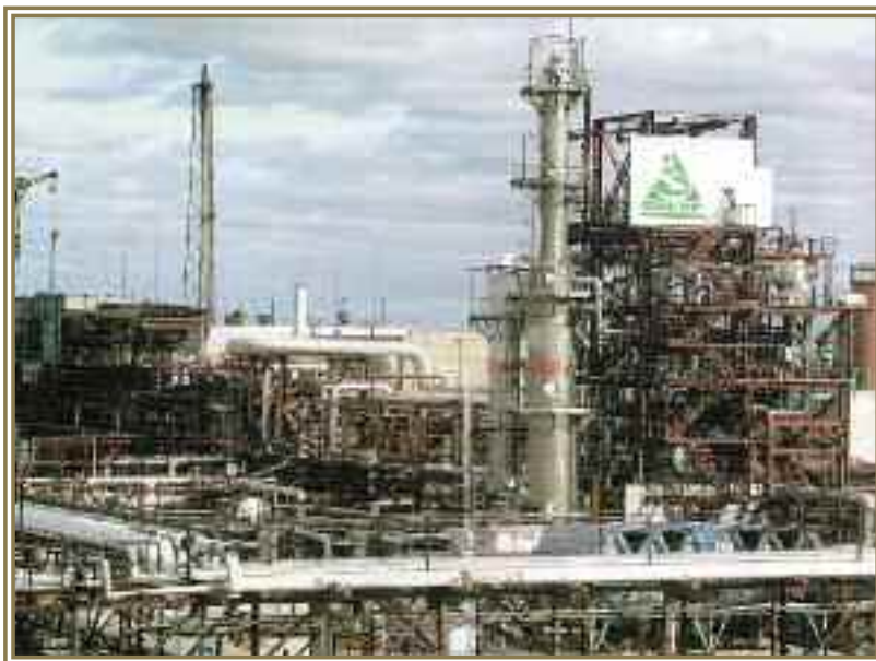
Губкинский газоперерабатывающий завод
