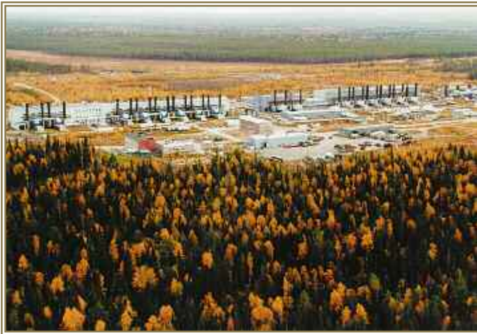
Компрессорная станция, Тюменская обл.
