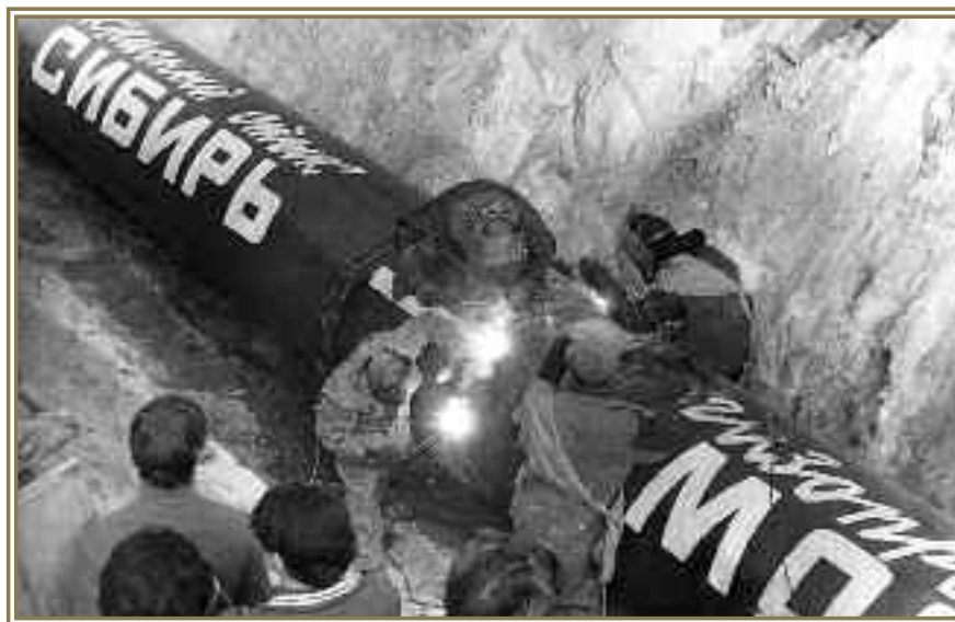
Идет сварка «Красного стыка», 1974 г.
