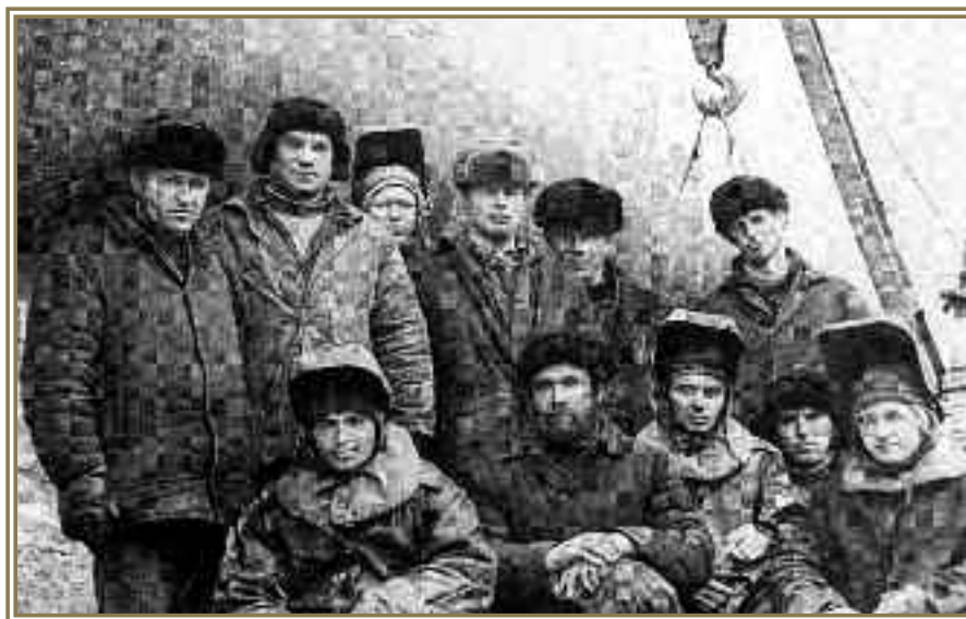
Сварочно-монтажная бригада И. Кунафина из треста Нефтепроводмонтаж, 1983 г.
