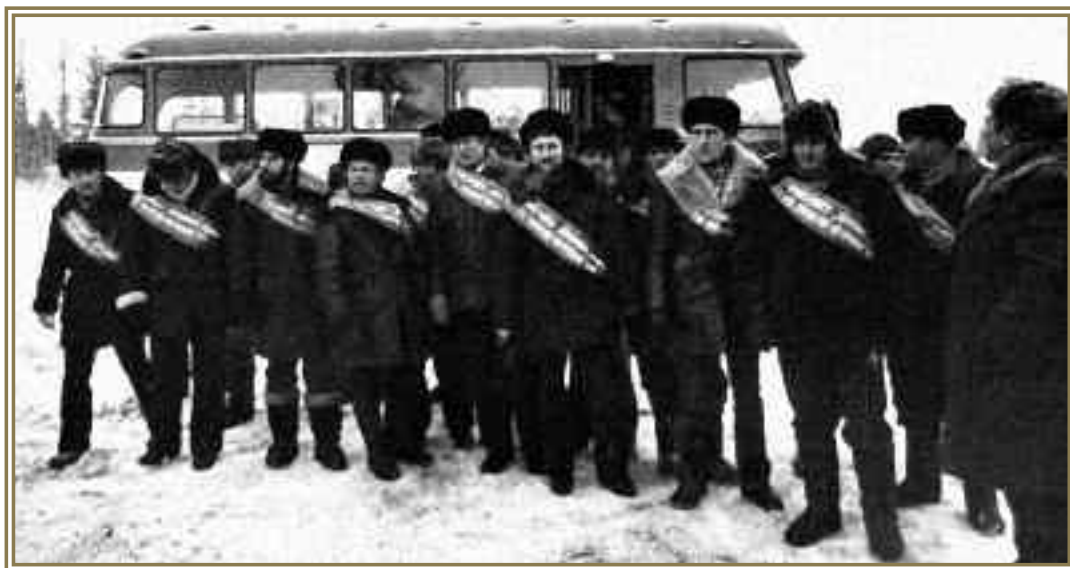
Газопровод Уренгой - Петровск
