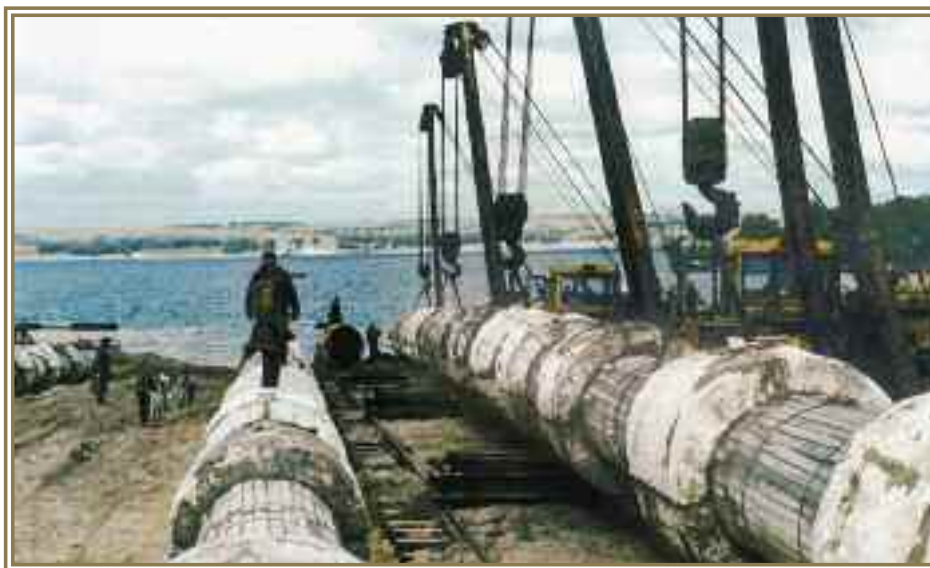
Преодоление реки Волги, газопровод Ямбург — Елец, 1988 г.
