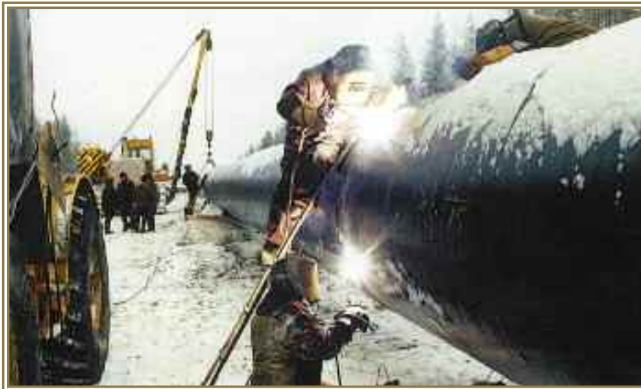
Ручная сварка трубопровода
