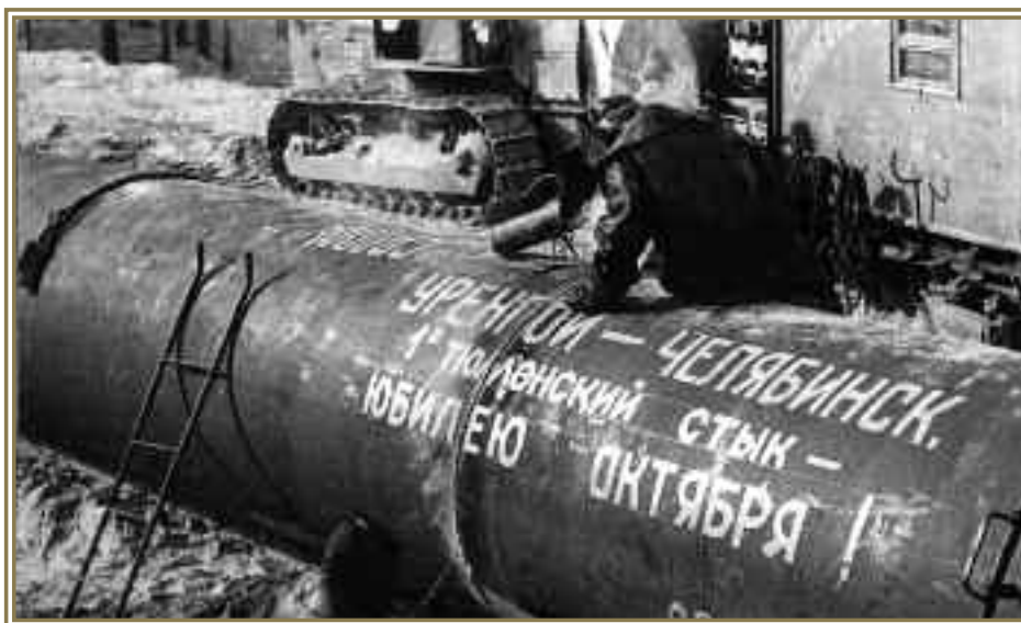
Первый тюменский стык, СУ-11, трест Севертрубопроводстрой, газопровод Уренгой — Челябинск, 1977 г.
