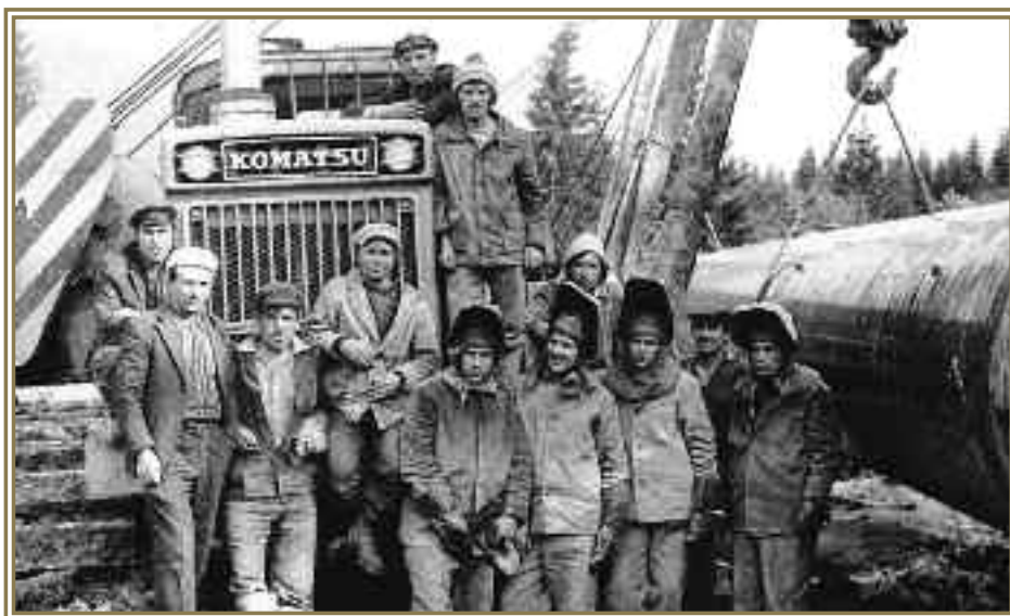
Сварочно-монтажная бригада треста Закнефтегазстрой, газопровод Уренгой — Помары — Ужгород, Карпаты, 1983 г.
