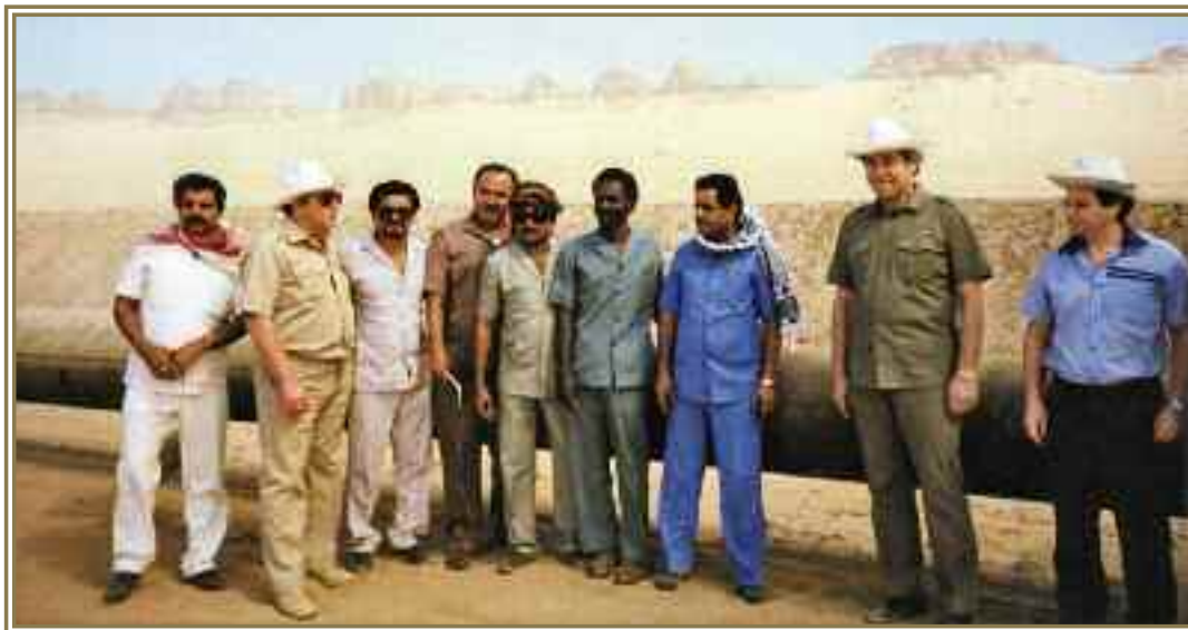
На строительстве нефтепровода в Народной Республике Йемен, 1989 г.
