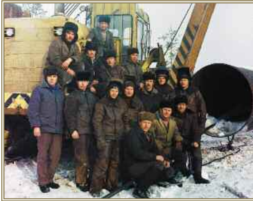
Сварочно-монтажная бригада А. Усикова из СМУ-12 треста Приобьтрубопроводстрой, газопровод Уренгой – Центр1, Тюменская область, 1984 г.
