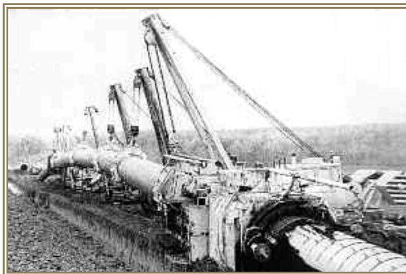
Изоляционно-укладочная колонна в работе
