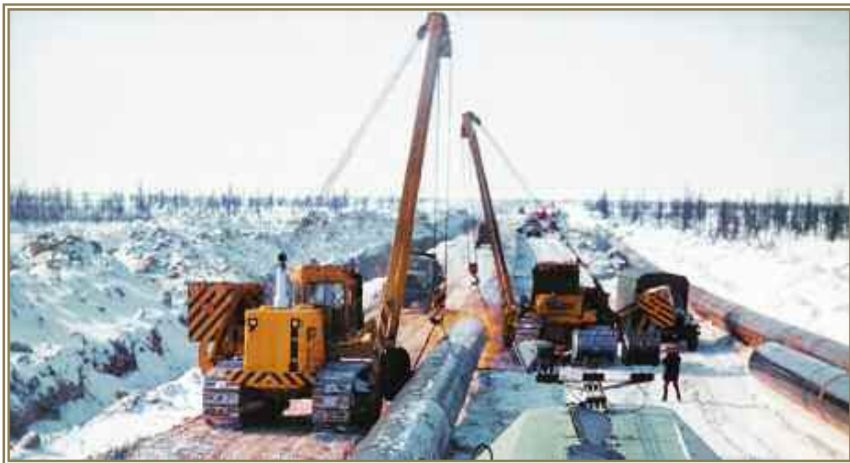
Автоматическая сварка газопровода, Ямало-Ненецкий округ, 1986 г.
