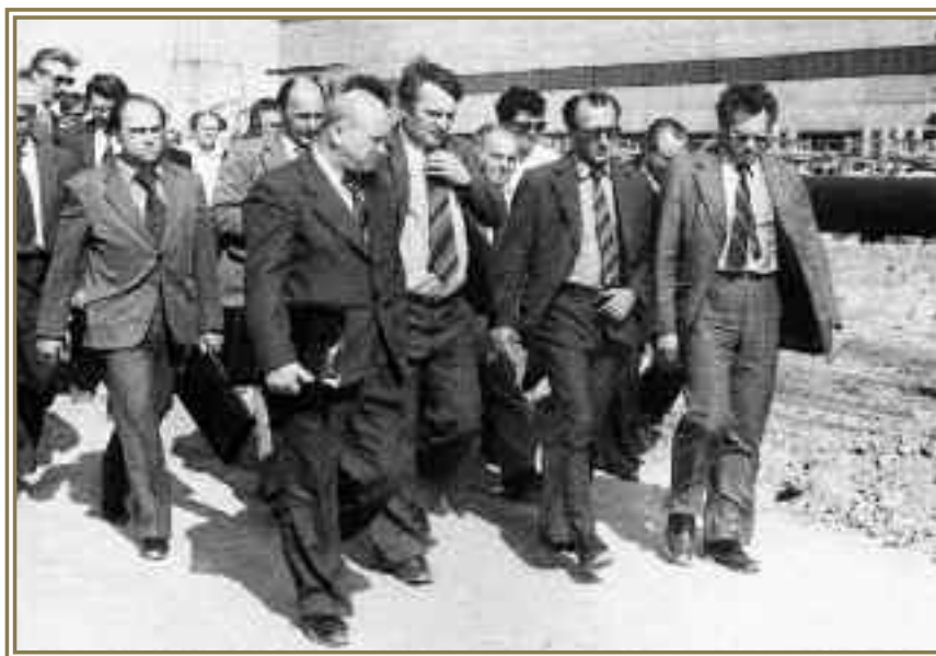
На строительстве компрессорной станции, Тюменская обл., 1985 г.
