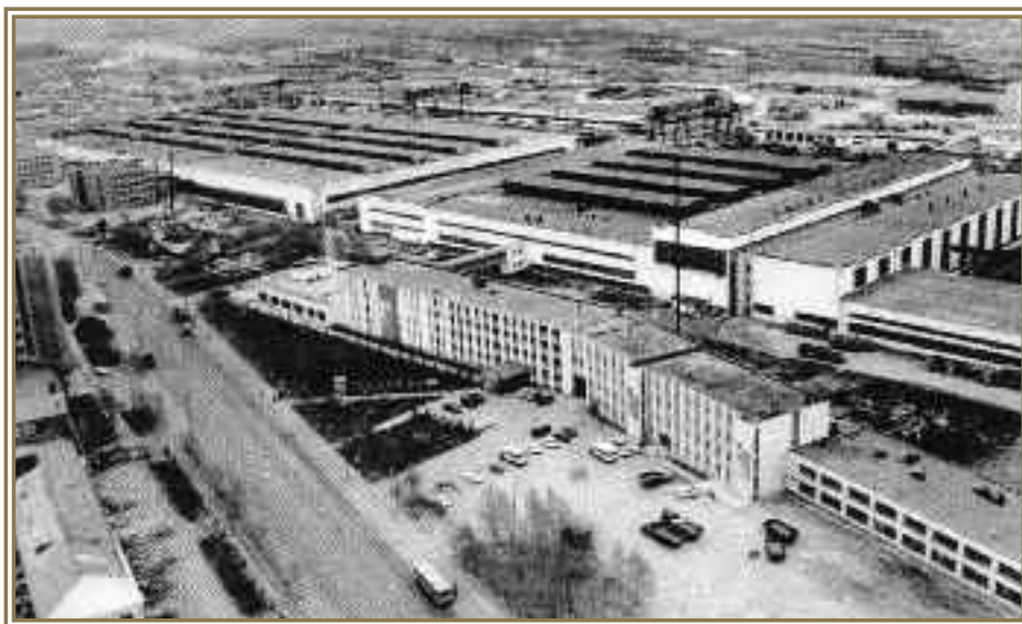
База объединения Сибкомплектмонтаж, г. Тюмень, 1986 г.
