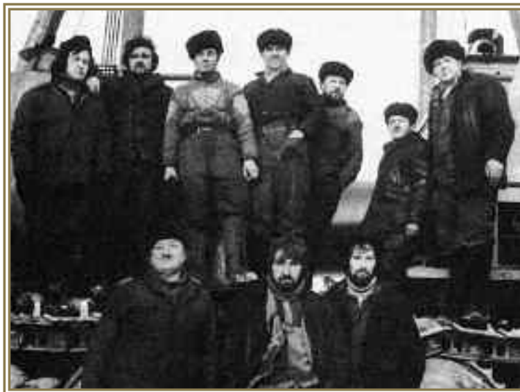
Изоляционно-укладочная коллона Б. Полющека, трест Севертрубопроводстрой, 1979 г.
