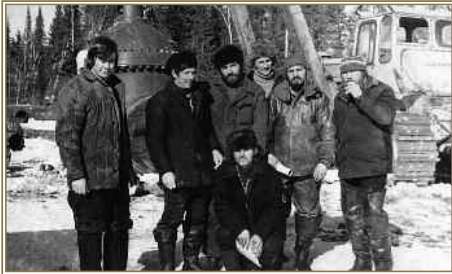
Сварочно-монтажная бригада Г.А. Косиненко, нефтепровод Сургут — Полоцк, 1979 г.
