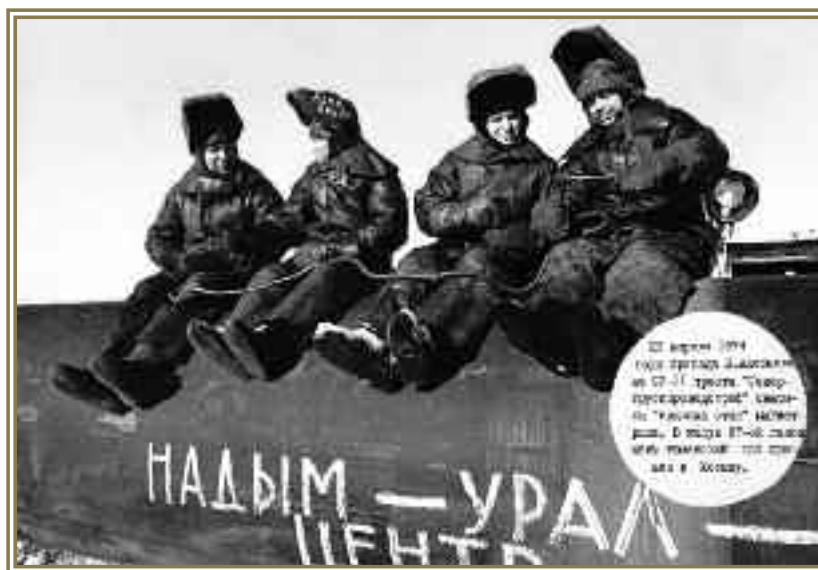
Бригада В. Алябьева из СУ-11 треста Севертрубопроводстрой, 1974 г.
