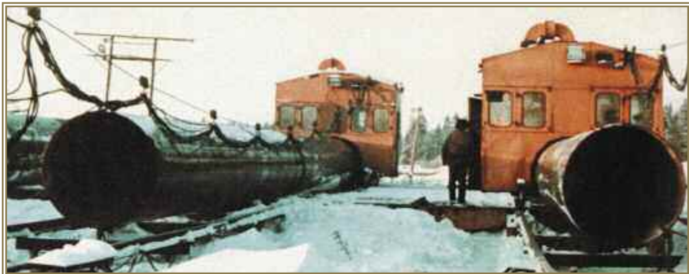
Поворотная сварка труб диаметром 1420 мм станция Полуночная, 1975 г.
