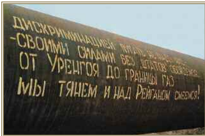
Газопровод Уренгой – Помары – Ужгород, 1983 г.
