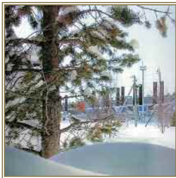
Вынгапурская компрессорная станция, Тюменская обл., 1982 г.
