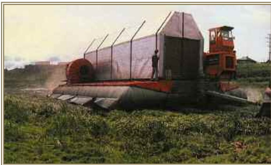
Транспортировка блока на воздушной подушке
