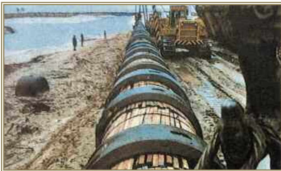
Трубопровод готов для подводного перехода, р. Обь
