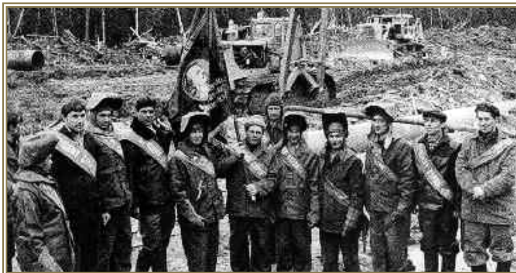
Сварочная бригада Николая Тягина треста Нефтепроводмонтаж, нефтепровод Нижнеартовск – Куйбышев, 1976 г.
