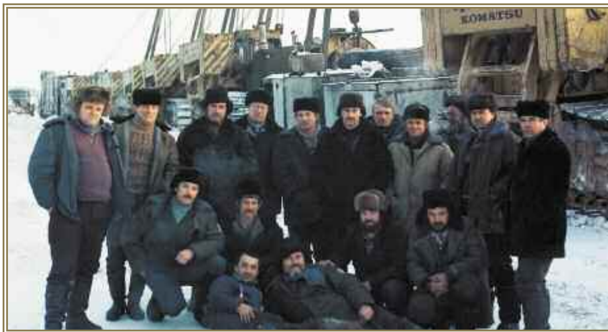
Изоляционно-укладочная колонна В.С. Бернадского, трест Приобьтрубопроводстрой, газопровод Ямбург – Поволжье, Тюменская обл., 1989 г.
