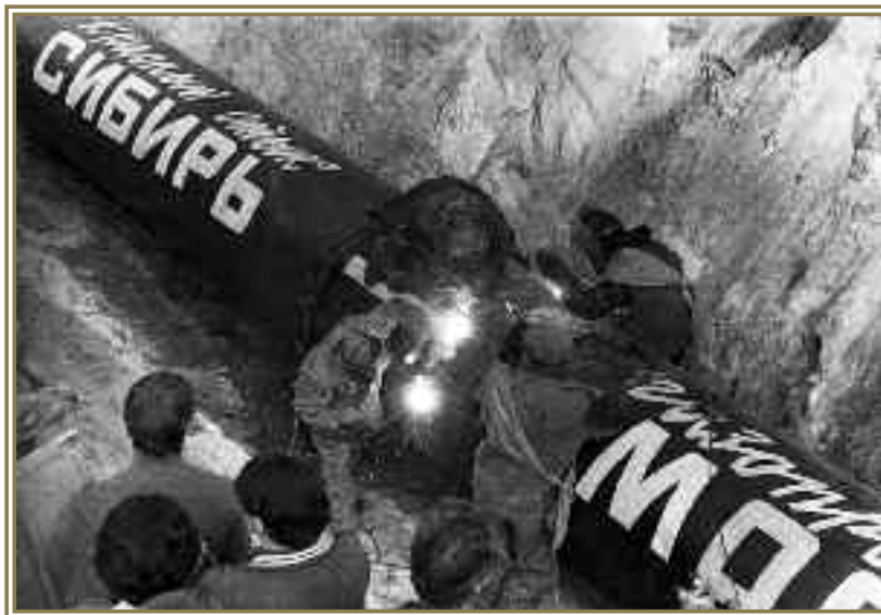
Газопровод Тюменская область – Москва, 1974 г.
