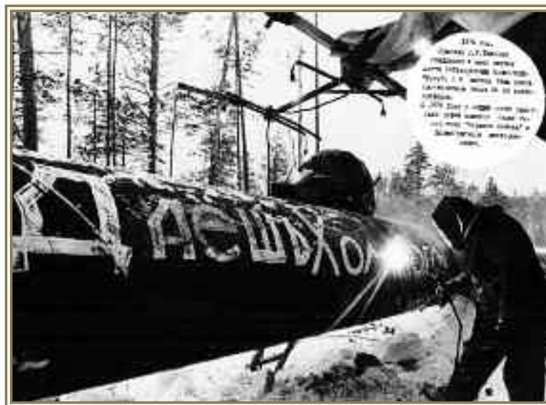
Бригада В.Г. Теплова на строительстве нефтепровода Холмогоры – Сургут, 1975 г.
