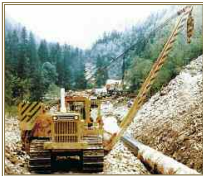
Трасса в горах Карпаты, газопровод Союз, 1978 г.
