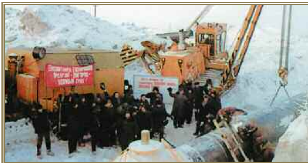
Газопровод Уренгой – Ужгород, Красный стык, Тюменская обл, 1983 г.
