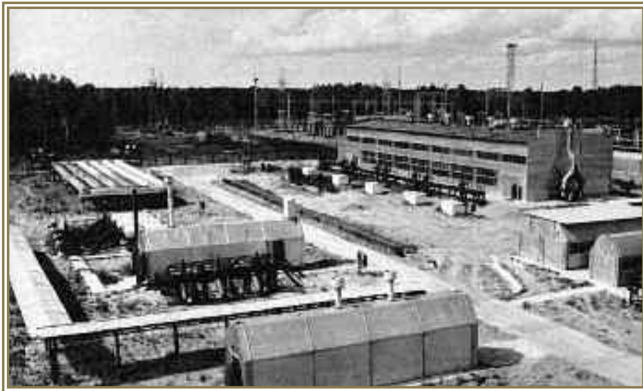
Нефтеперекачивающая станция на трассе нефтепровода
