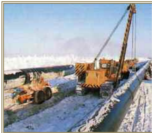
На трассе трубопровода, Ямал
