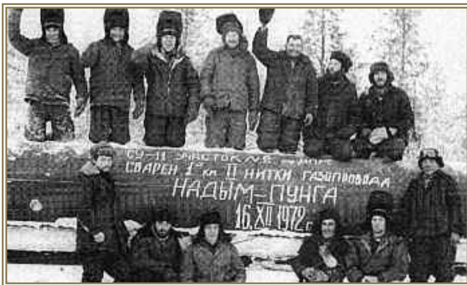
На газопроводе Надым – Пунга, Тюменская область
