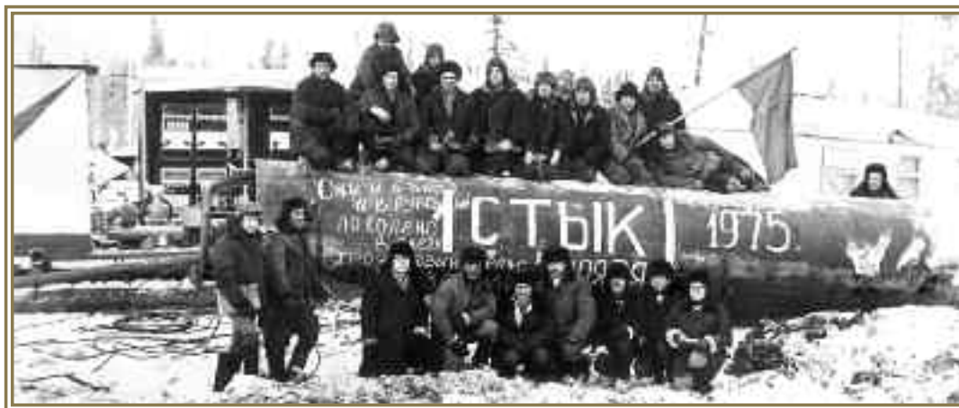
Работники СМУ-5 треста Севертрубопроводстрой, газопровод Надым — Пунга 3, 1975 г.
