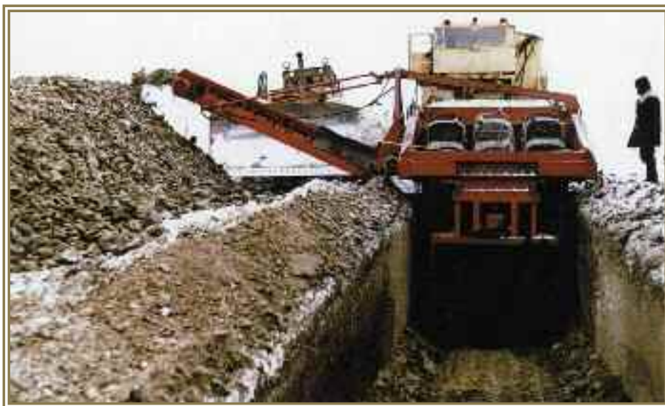
Роторный экскаватор в работе
