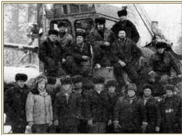
Изоляционно-укладочная колонна В.А. Белоусова. Трест Комсомольсктрубопроводстрой. 1979 г.
