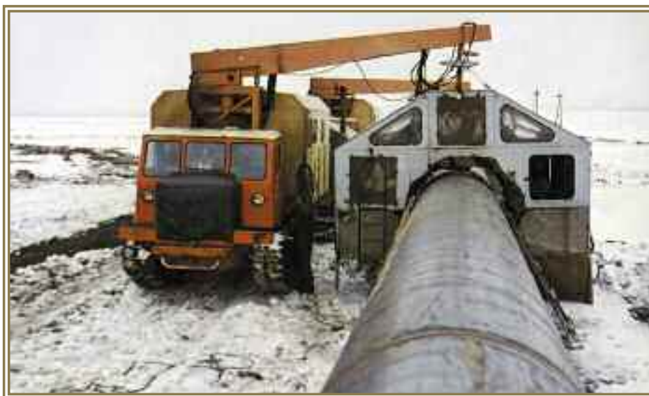
Сварочный комплекс «Стык» в работе
