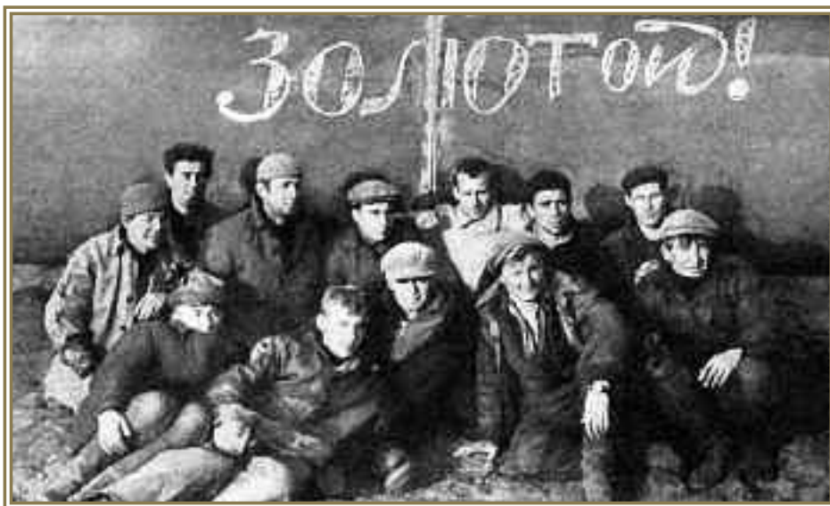
Бригада Сварочно-монтажного треста. Газопровод СРТО – Торжок, 1976 г.
