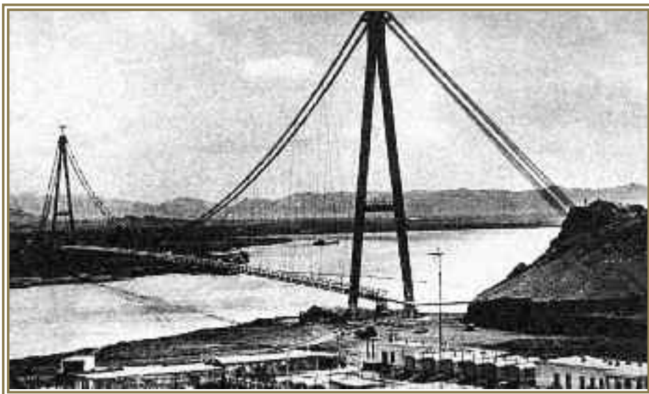
Вантовый мост через Амударью в районе пос. Келиор
