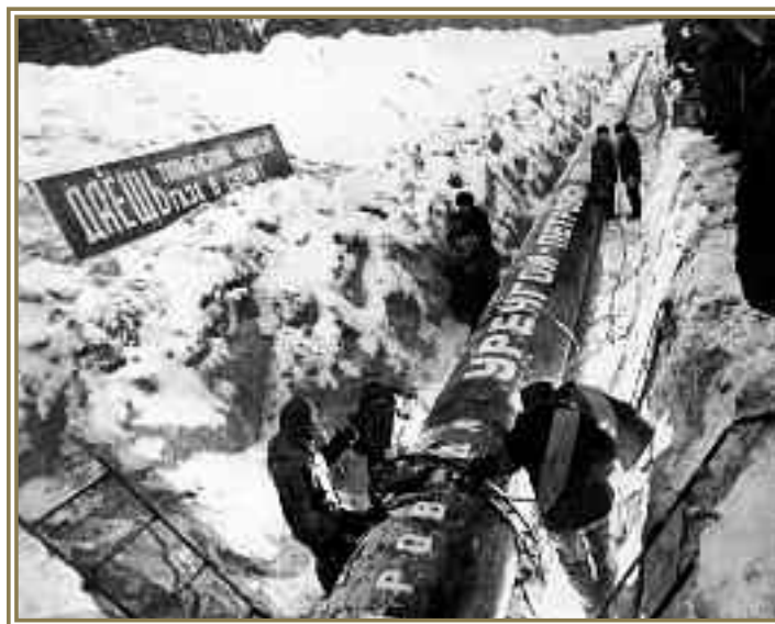
Газопровод Уренгой - Петровск
