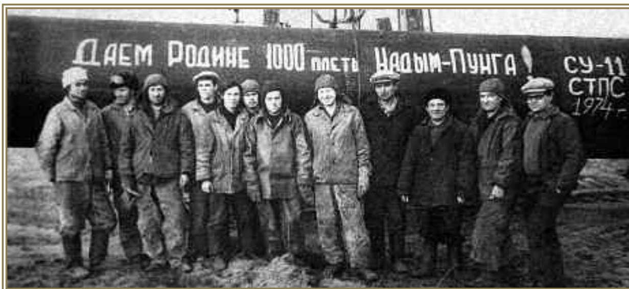
Сварочно-монтажная бригада А.С. Костырева, СУ-11, треста «Севертрубопроводстрой», газопровода Надым – Пунга, 1974 г.
