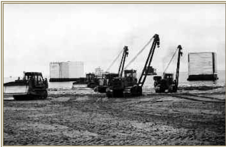
Суперблоки установки комплексной подготовки газа по водным путям из г. Тюмени доставлены в Ямбург, 1986 г.
