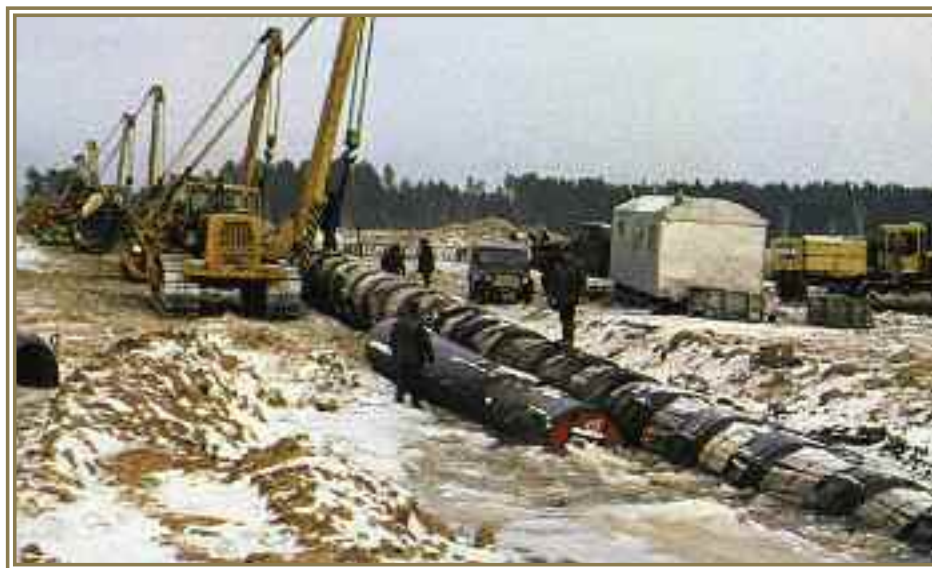
Укладка трубопровода на дно реки
