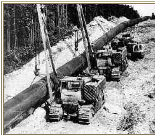
На трассе трубопровода
