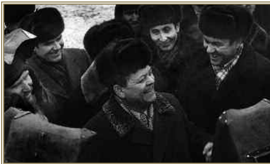
Душевный разговор в бригаде электросварщиков на трассе газопровода, Тюменская область, 1974 г.
