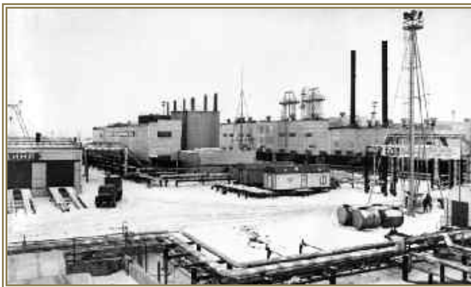
Установка комплексной подготовки газа
