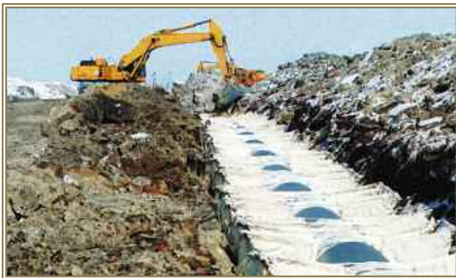
Пригрузка трубопровода грунтом
