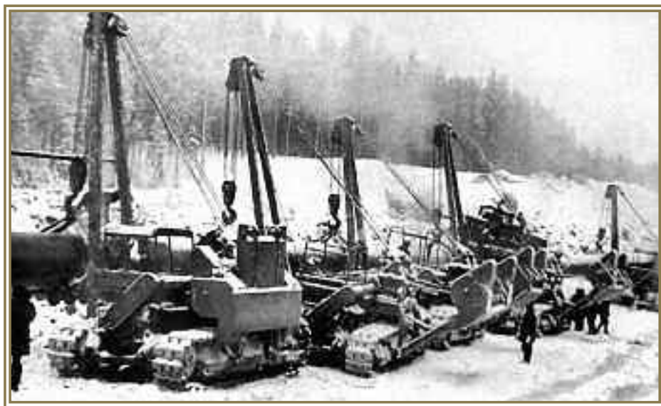
Изоляционно-укладочная колонна СУ-2 Сварочно-монтажного треста в работе 1973 г.
