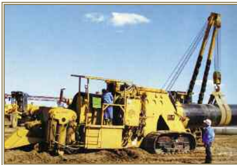
Трубогибочная машина в работе
