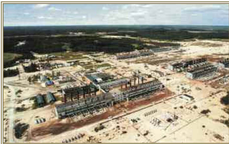
Компрессорная станция Лон-Юган, Тюменская обл.
