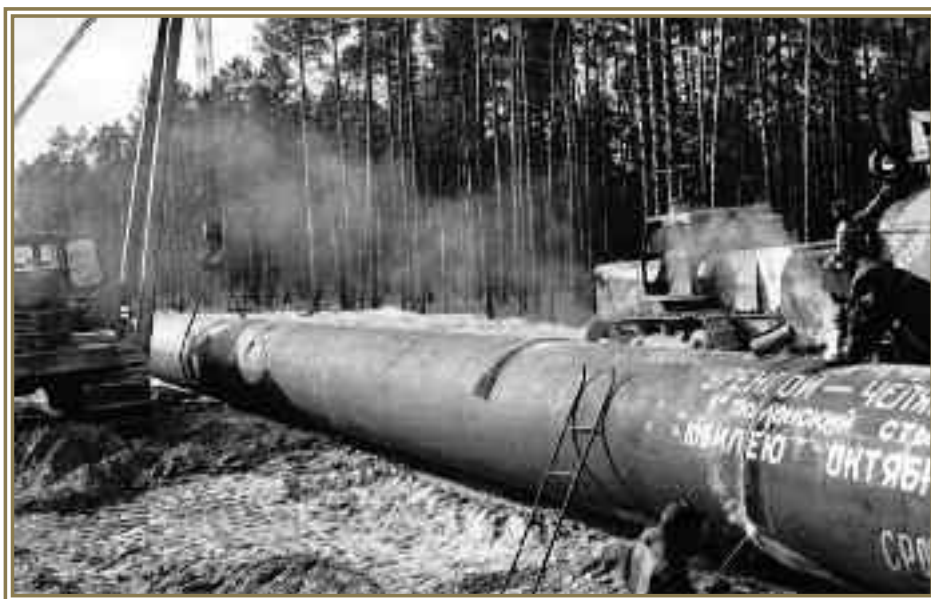
Газопровод Уренгой – Челябинск, Тюменская обл., 1977 г.
