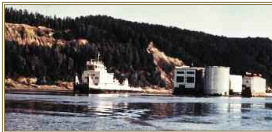
Транспортировка суперблоков, р. Иртыш 1984 г.
