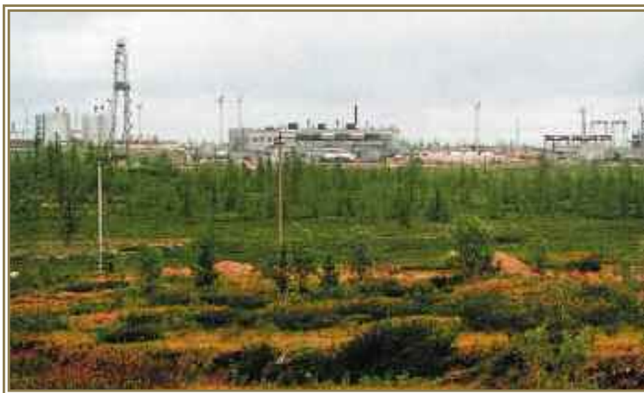
Газовый промысел Медвежьего месторождения, Ямал
