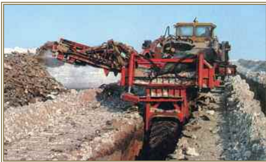
Работа роторного экскаватора в условиях вечномёрзлых грунтов
