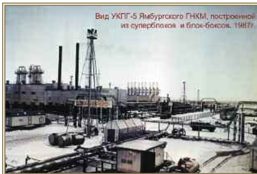
Установка комплексной подготовки газа №5, Ямбург, Тюменская обл., 1987 г.
