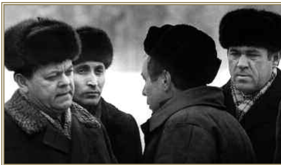
Б.Е. Щербина беседует с бригадиром В.А. Благодатским на строительстве нефтепровода Нижневарковский — Куйбышев, Тюменская обл., 1975 г.
