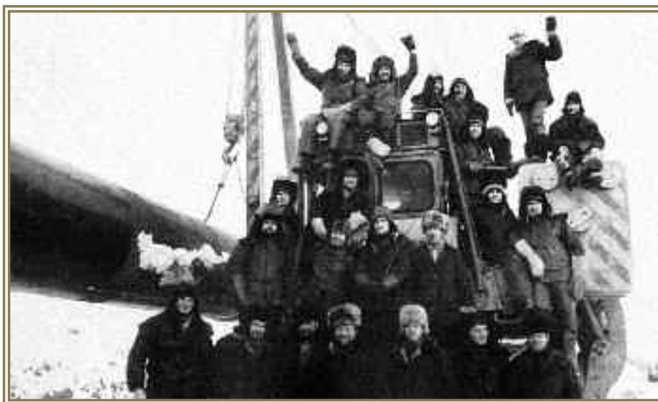
Сварочно-монтажная бригада Б. Терещенко, трест Севертрубопроводстрой, Ямбург – Елец, Тюменская обл., 1985 г.
