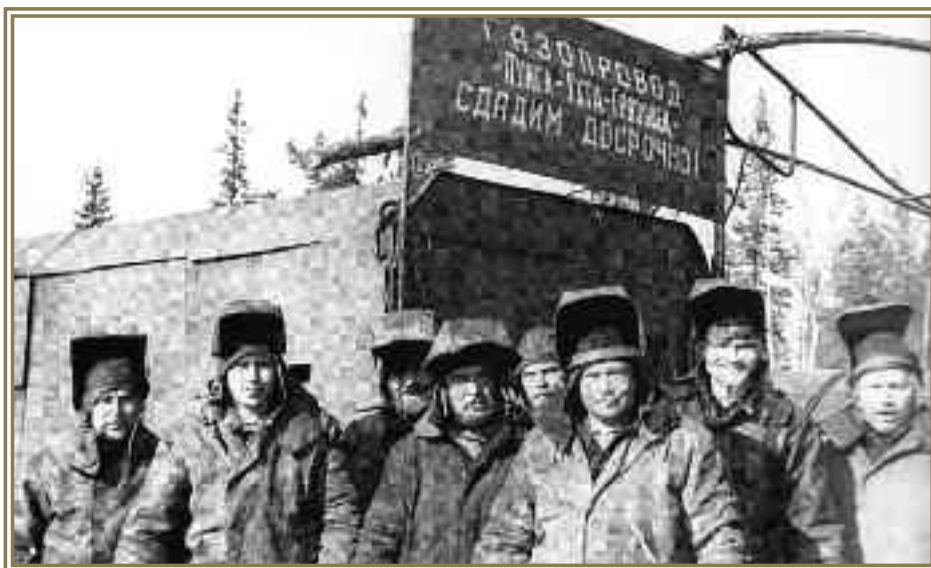
Сварочно-монтажная бригада М. Галямутдинова из СМУ-74, газопровод Пунга — Ухта — Грязовец, 1981 г.
