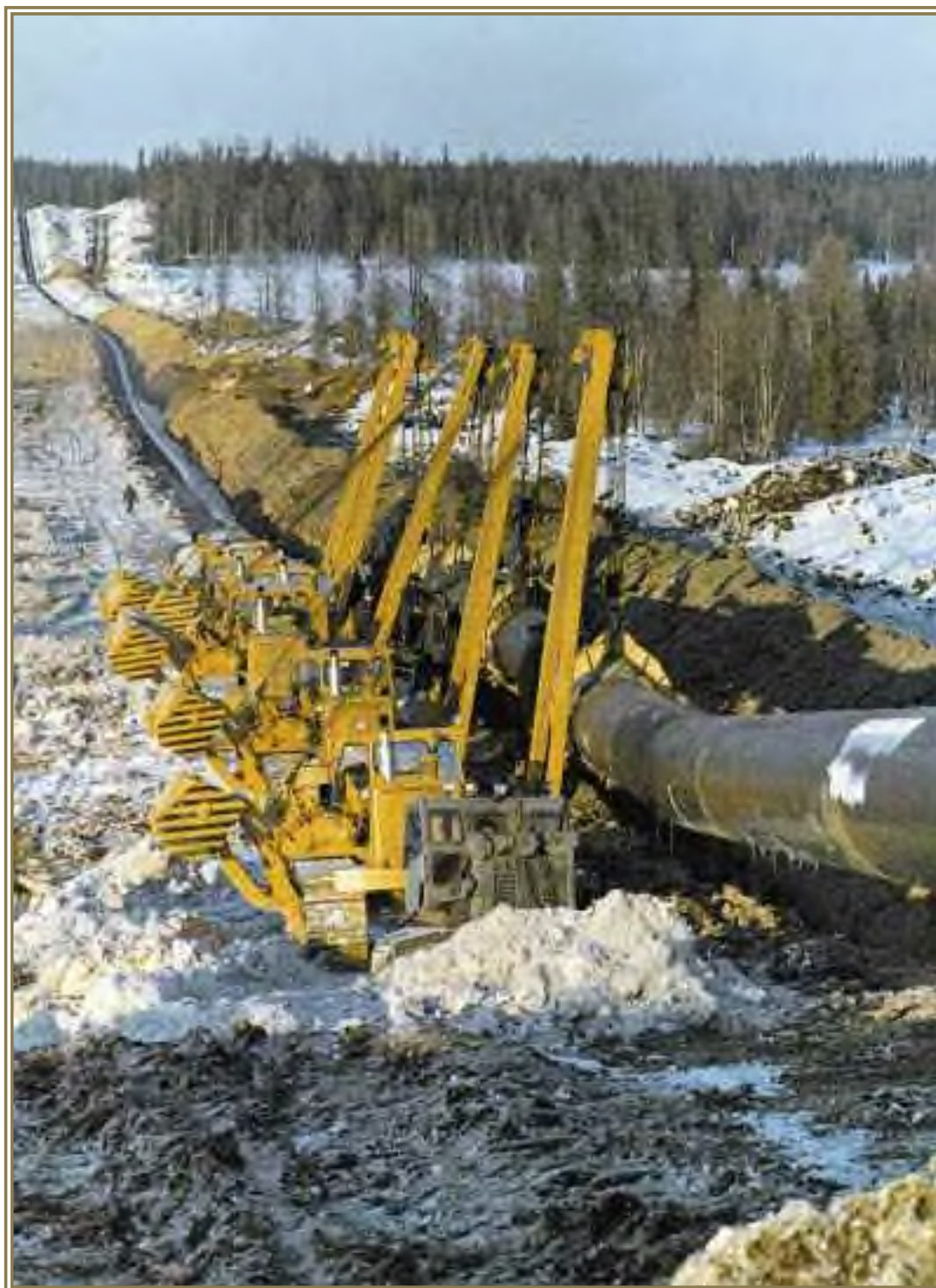
Изоляционно-укладочная колона в работе
