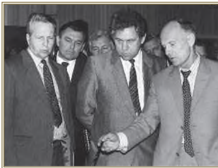
Руководители государства на строительстве газлифтной компрессорной станции. Саянтлор. Тюменская обл. 1985 г.
