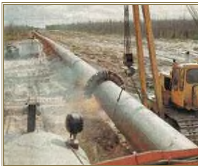
Н. Курбатов, В. Чирсков, А. Белоглазов, Н. Кизуб на строительстве газопровода Уренгой-Челябинск. Тюменская обл. 1978 г.
